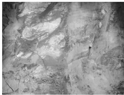
图8 前埭隧道进口右洞 YK17+187 掌子面上的管流图
