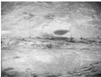
图7 前埭隧道进口右洞 YK17+175 掌子面上的地质构造带图
