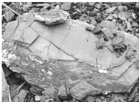
图 3 隧道内岩块的崩解图
