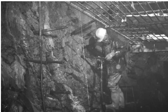
(a) 注浆锚杆的安装
