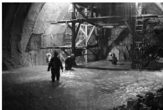
(b) 断面突水、涌水勘察
