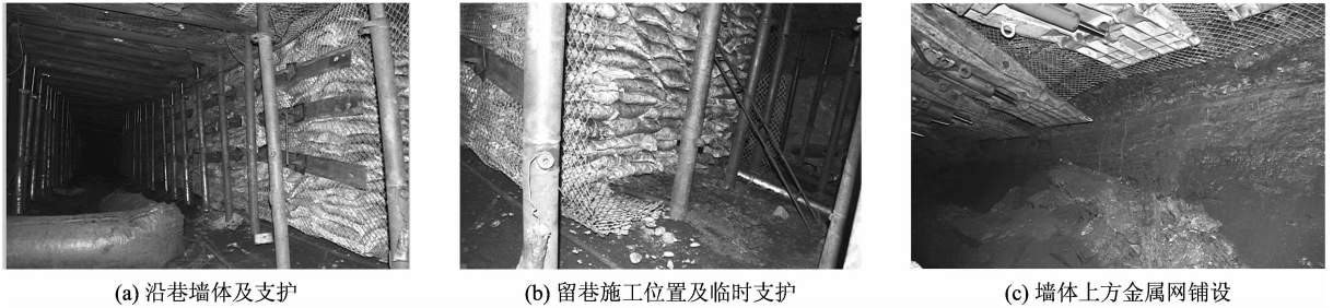
(a) 沿巷墙体及支护
