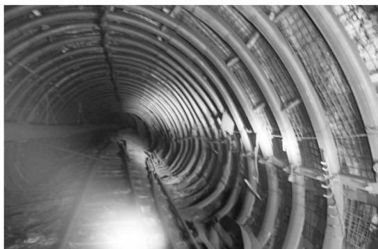
图 3 D 型钢管支架实际支护效果图
