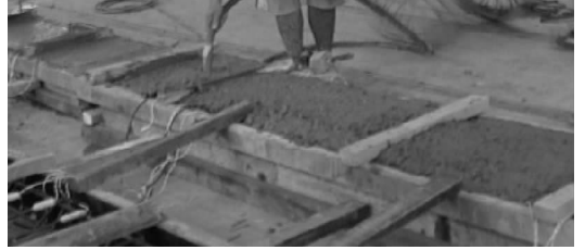
图 8 混凝土现场浇筑
