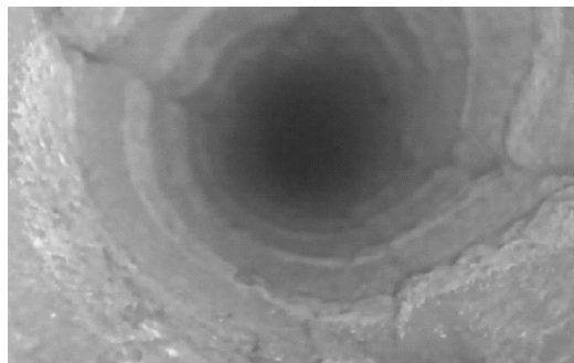
图 15 炮孔长度 18 m 堵塞长度 6 m 时爆破后孔内窥视图
