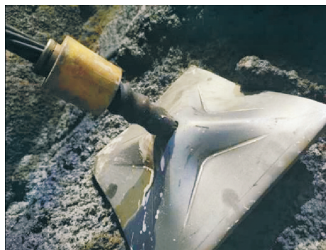
图 14 梯度增阻让压支护结构现场应用
